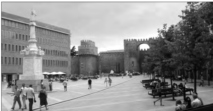
Figura 4 Vista de la Plaza del Mercado Grande (Ávila). Contraste e impacto del edificio de nueva construcción (Moneo) y Puerta del Alcázar de la muralla
