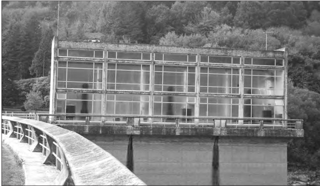
Figura 8 Subestación de la presa de Belesar
